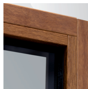
Lícování světlíku z vnitřní strany
