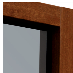
Lícování světlíku z venkovní strany
